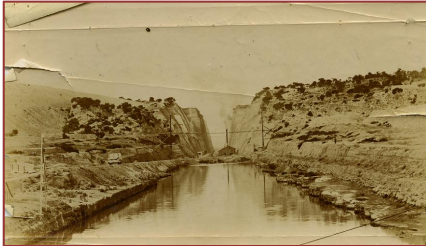
Εικ. 11. Άποψη της διώρυγας από τη γέφυρα των Ισθμίων (Archives historiques de BNP Paribas-11FI77EL)
