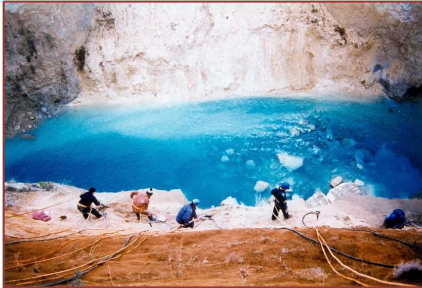
Εικ. 30. Εργάτες συντηρούν τα πρανή της διώρυγας. (φωτ. από το αρχείο του κ. Δ. Ξύπα)
