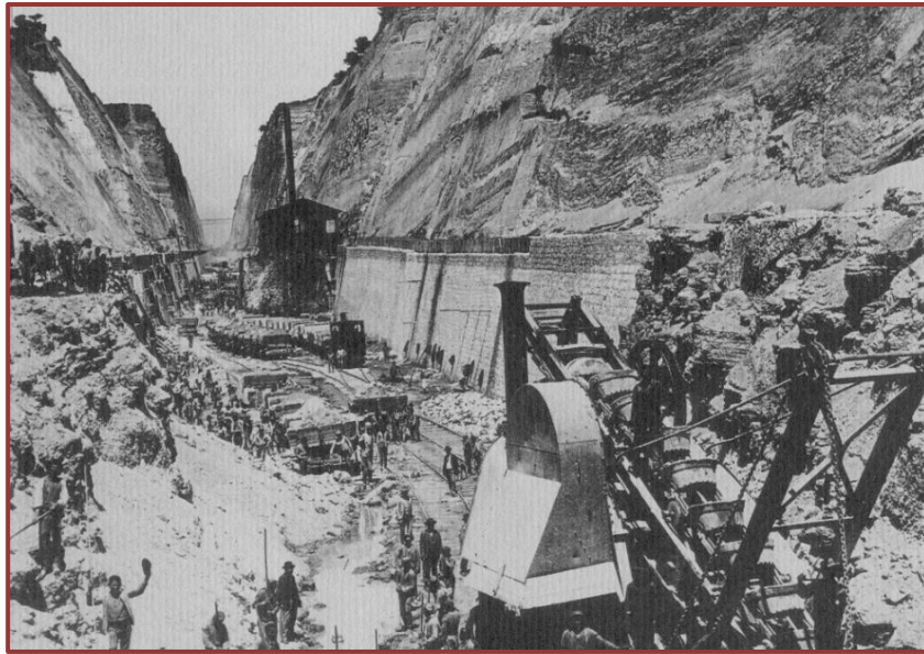
Εικ. 7. Από τα έργα διάνοιξης της διώρυγας ( https://corinthcanalsupcrossing.gr/corinth_canal_history/ )
