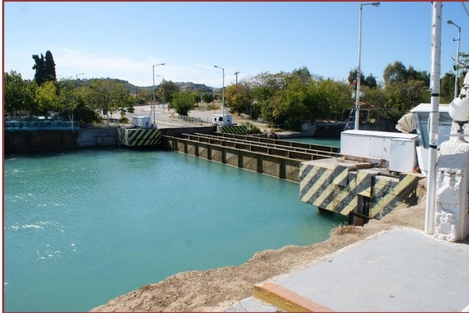
Εικ. 12. Η βυθιζόμενη γέφυρα της Ισθμίας, την ώρα που αναδύεται, 2014.
