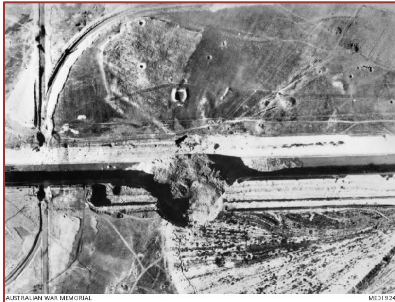
Εικ. 22. 15 Οκτωβρίου 1944. Αεροφωτογραφία της κατεστραμμένης σιδηροδρομικής γέφυρας από τους Γερμανούς. https://www.awm.gov.au/collection/C366762
