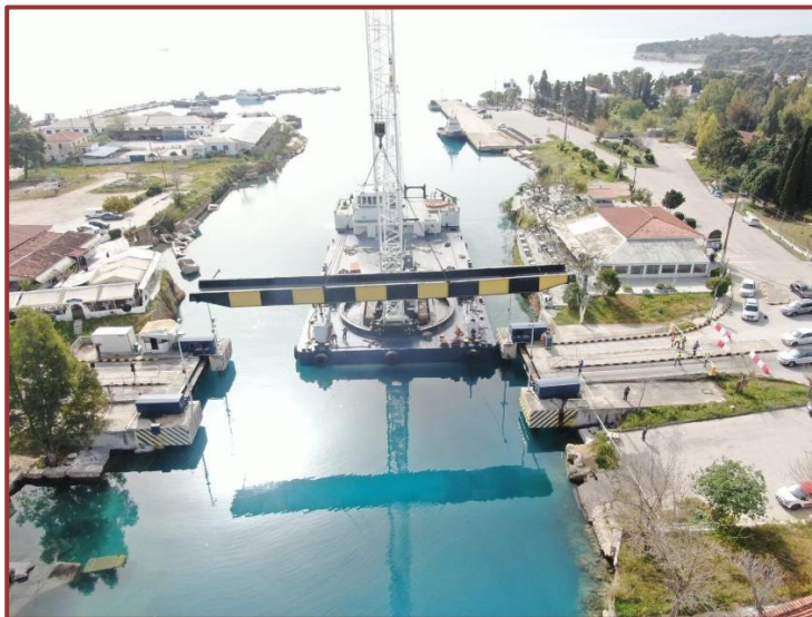
Εικ. 27. Εξάρμωση και μεταφορά γέφυρας Ισθμίας με γερανό (2024) https://corinthcanal.com
